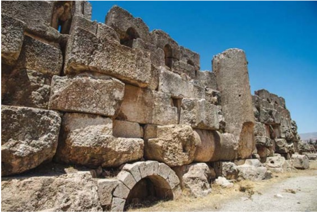
42. Un muro di fortificazione costruito dagli arabi a Baalbek servendosi di materiali romani riciclati. Si noti il tamburo di colonna posto orizzontalmente a destra dell'arco.
