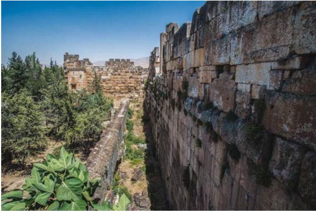
44. Il braccio settentrionale del muro megalitico a U che circonda la piattaforma del Tempio di Giove. Si noti che i blocchi che compongono la piattaforma stessa (a destra nella foto) sono più piccoli.
